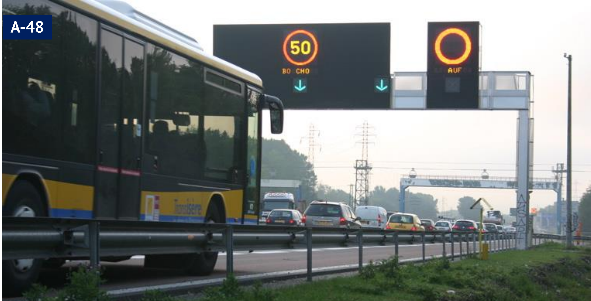
Carril bus sobre arcén en el acceso a Lyon
